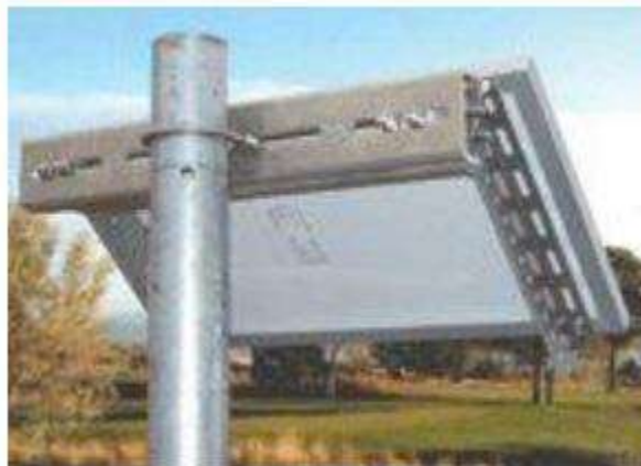
Fig. 4. Suport de montaj pe stâlp pentru panourile fotovoltaice [7]
